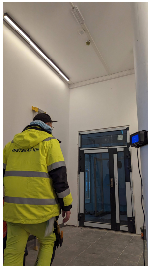
Nyvold Installasjon bygger sitt eget kontorlokale på Oppdal.
