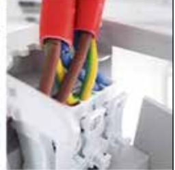
Skade: Løstingene fra 1000 kV-linje, ettersom den ikke beskyttes, kan den bli skadet. Foto: DLE
