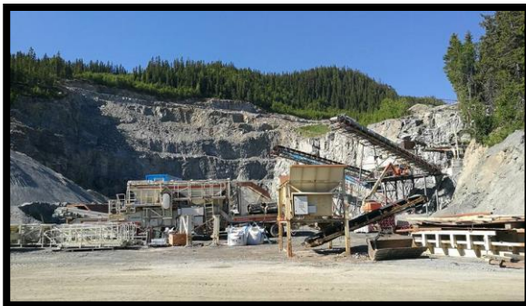
Caverion Orkanger på Gjølme pukkverk
